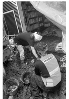
土砂の撤去作業を行うボランティアの方々
