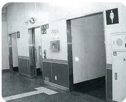
点字による案内版が設置され、音声での案内は常時流れている（JR東海道線改札内トイレ）
