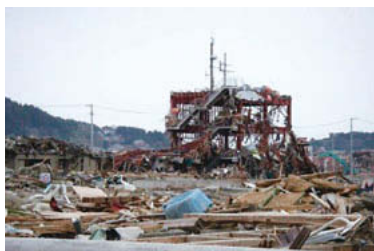
宮城県南三陸町の防災対策庁舎の惨状
